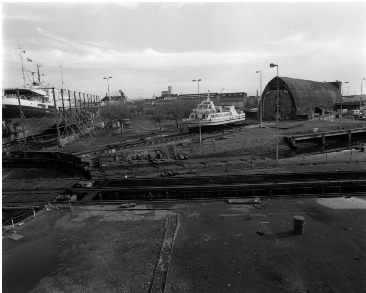
Vue des lignes de réparation navale n° 7 (dom-bunker ouest), n° 1 (dom-bunker est) et n° 2. Au centre, la rampe inclinée ou cale du slipway
