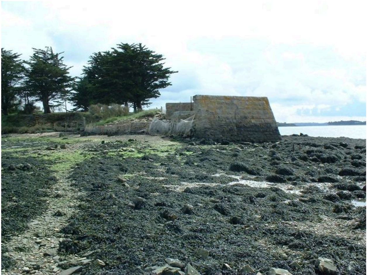
Vestiges de la vanne du Grand Pont (flot Bechit)
