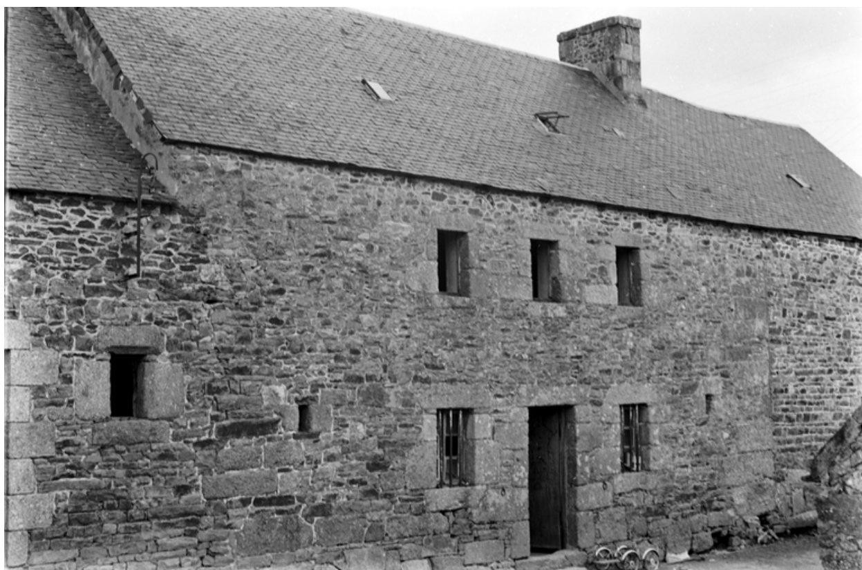
Maison (Goarem Baler) : vue de la façade antérieure
