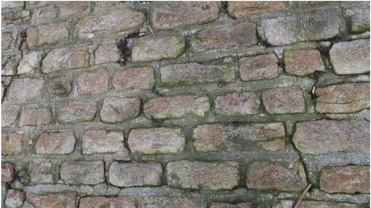
Cale du passage : dallage en pavés
