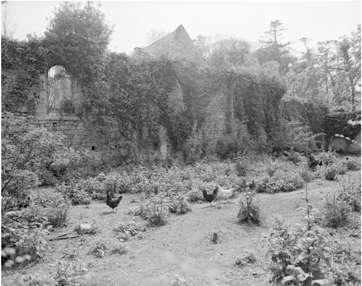
Mur sud de l'ancienne chapelle Saint-Nicolas formant aujourd'hui clôture au nord de la cour. Vue prise du nord. (1983)
