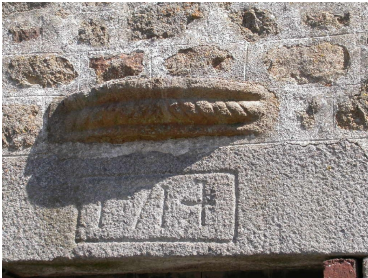
Détail du linteau
