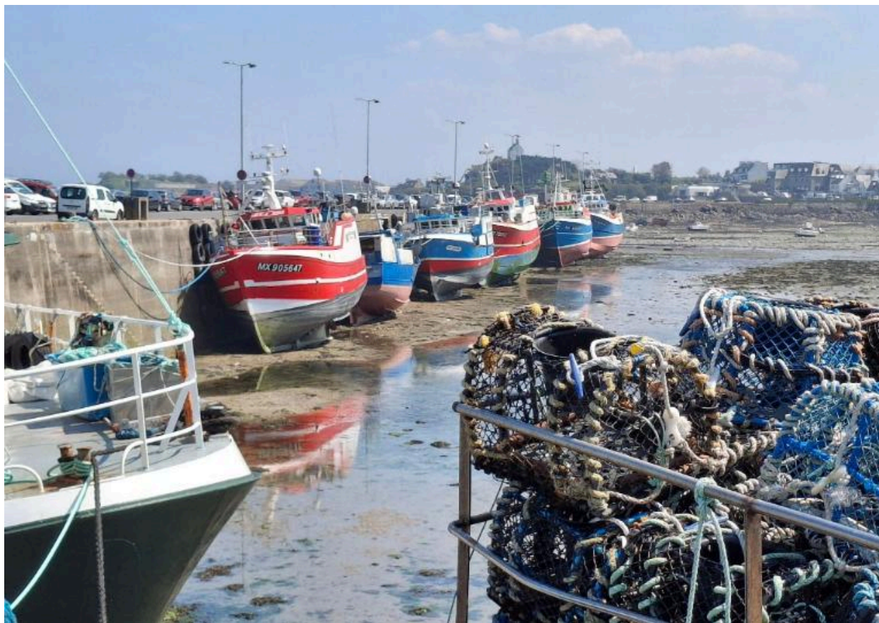
Nouveau quai et bassin du port de pêche
