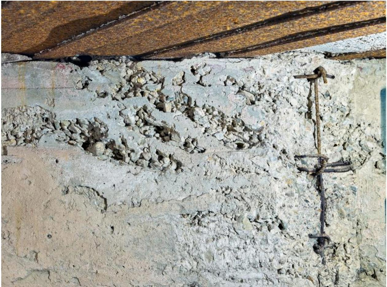
Vue de détail du béton armé constitué majoritairement de granulats sans ciment. A certains endroits, les fers à béton sont visibles du fait de la corrosion (Bunker - casemate de type 680 pour un canon de 7,5 cm ou 7,62 cm situé au Sud)
