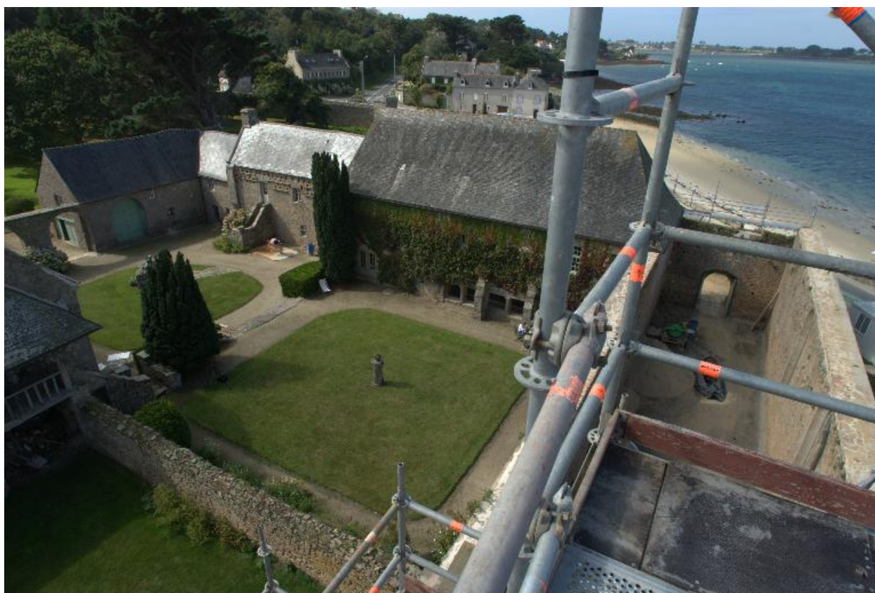
Vue de situation de l'ancien couvent en restauration prise depuis les échaffaudages
