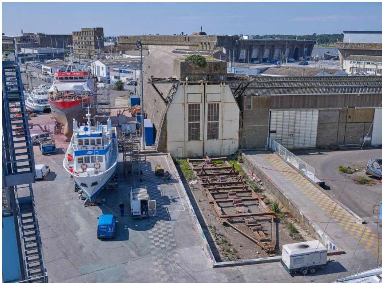
Vue de situation depuis le sommet de l'élévateur à bateaux de l'aire de réparation navale. Sur le terre-plein, des chalutiers en maintenance
