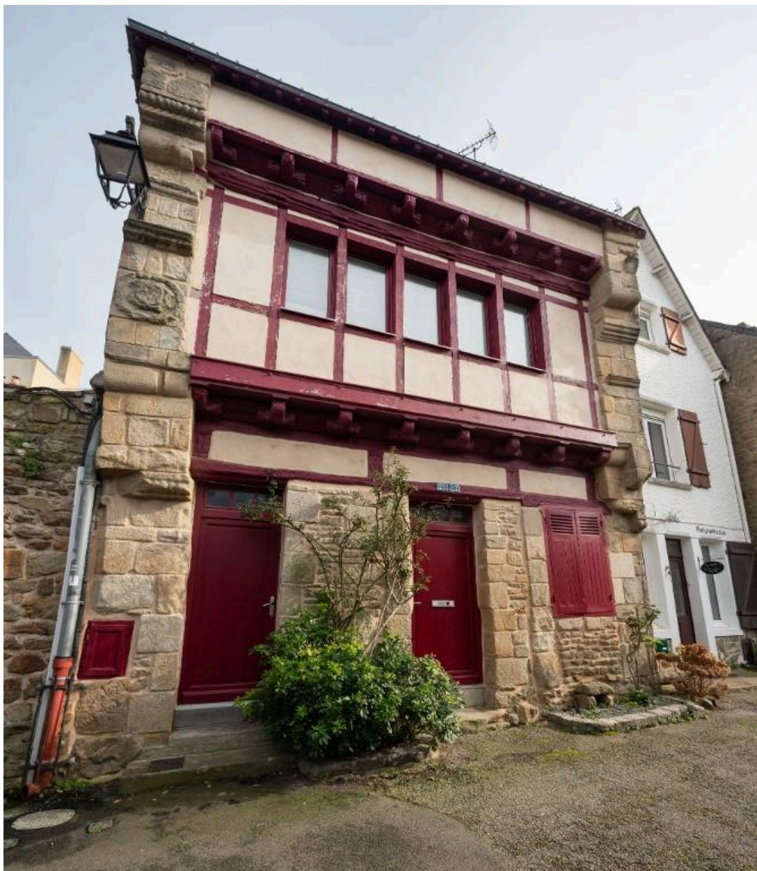
Façade à gouttereau sur rue, en pan de bois en encorbellement.
