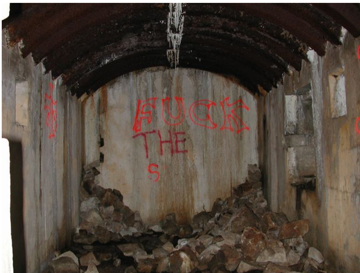
Vue intérieure (état en 2002)
