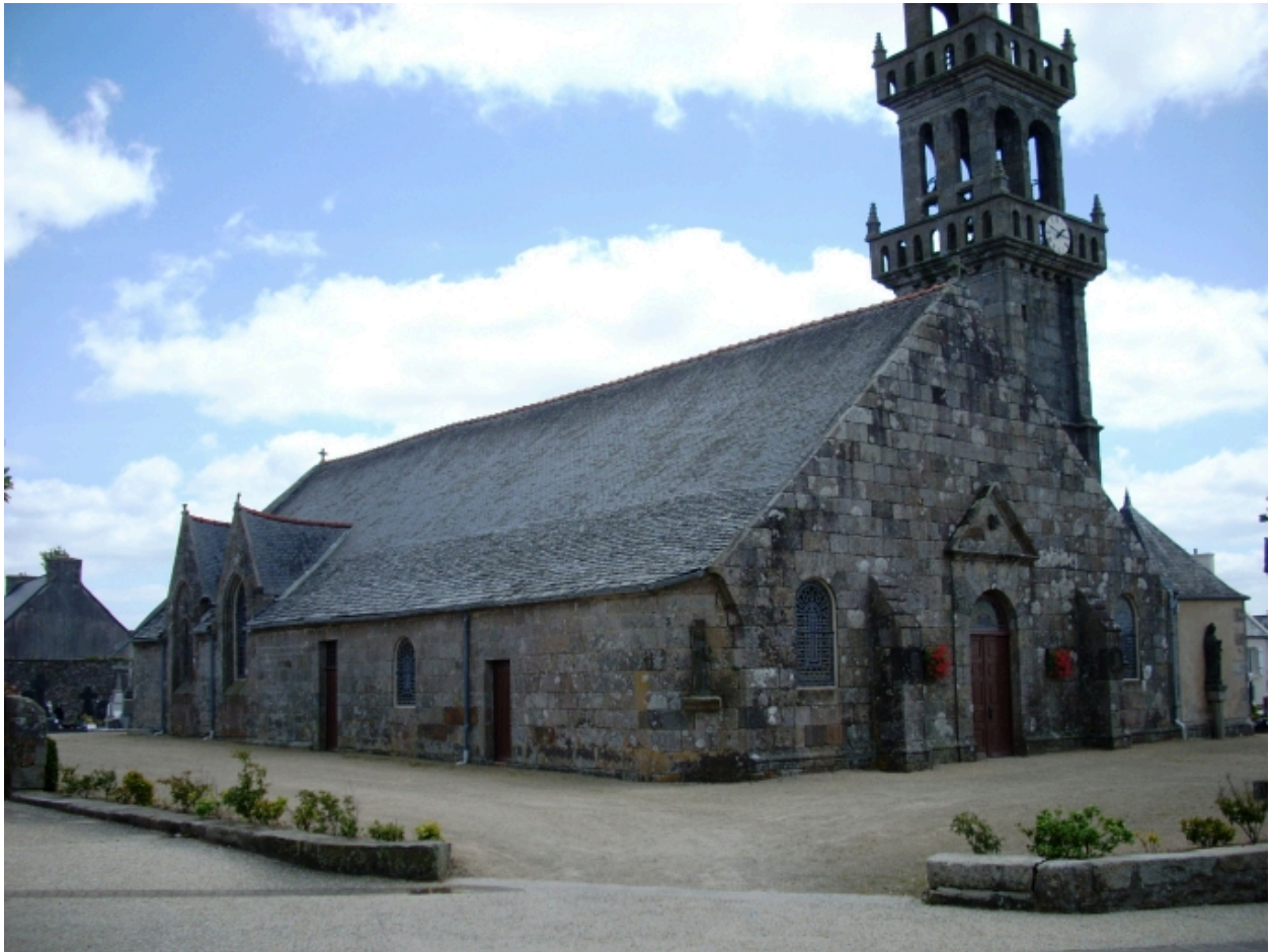
Saint-Vougay, église paroissiale Saint-Vougay : vue générale nord-ouest
