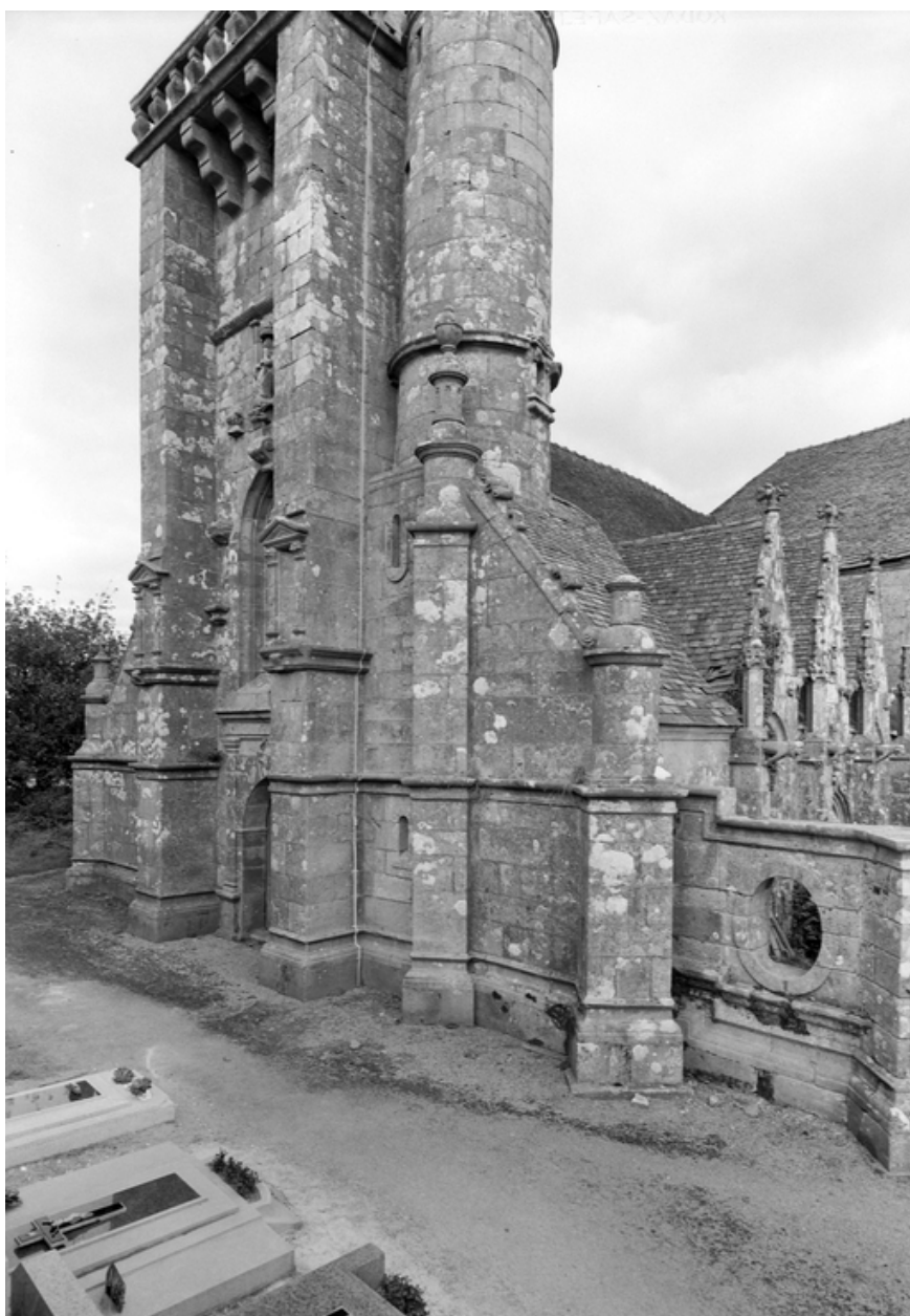
Vue générale de la façade ouest
