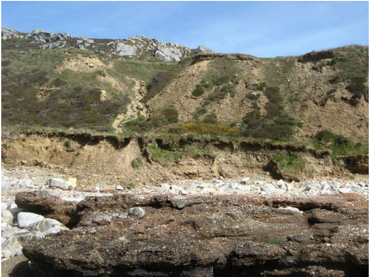
Vue longitudinale du site portuaire de Porzh Koubou avec grève de galets en partie cimentés au 1er plan
