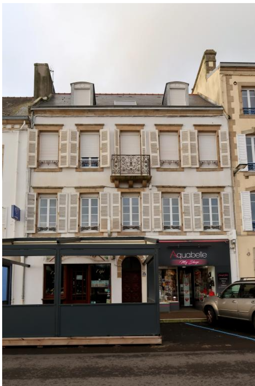
Immeuble au 6, quai Jean Jaurès, élévation antérieure. (2020)
