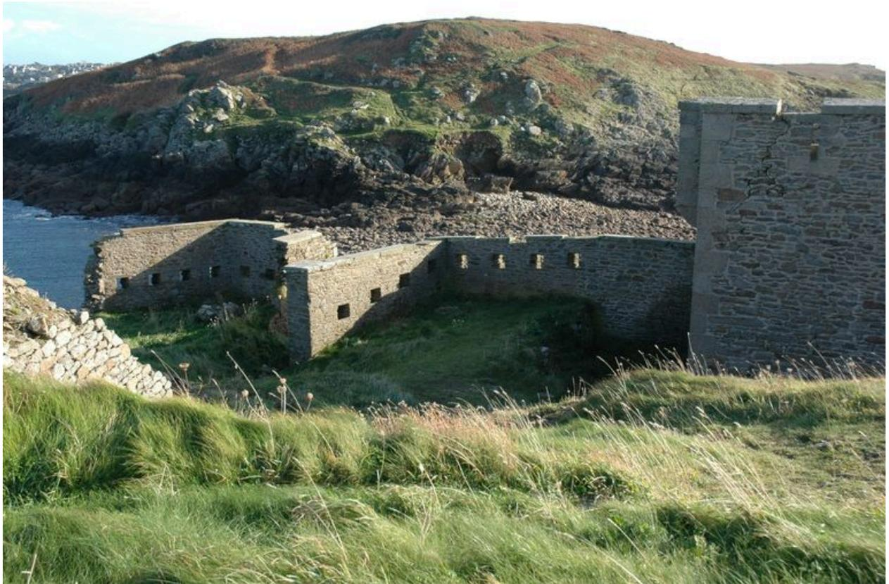
L'entrée est encadrée par un mur défensif percé de créneau de fusillade. Noter la lézarde à l'angle Nord-est de réduit
