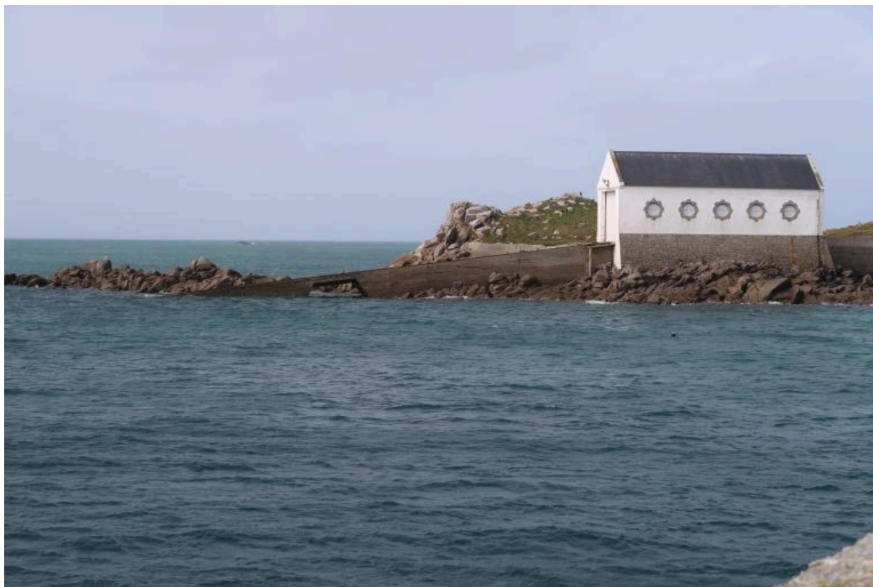
Abri du canot de sauvetage et cale avec rampe de mise à l'eau
