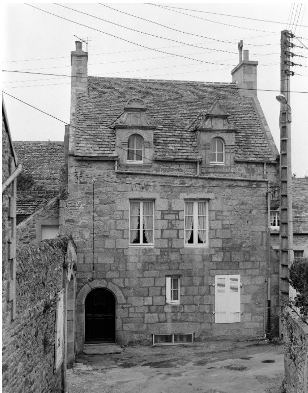
12 rue Yan d'Argent, élévation sud, vue générale
