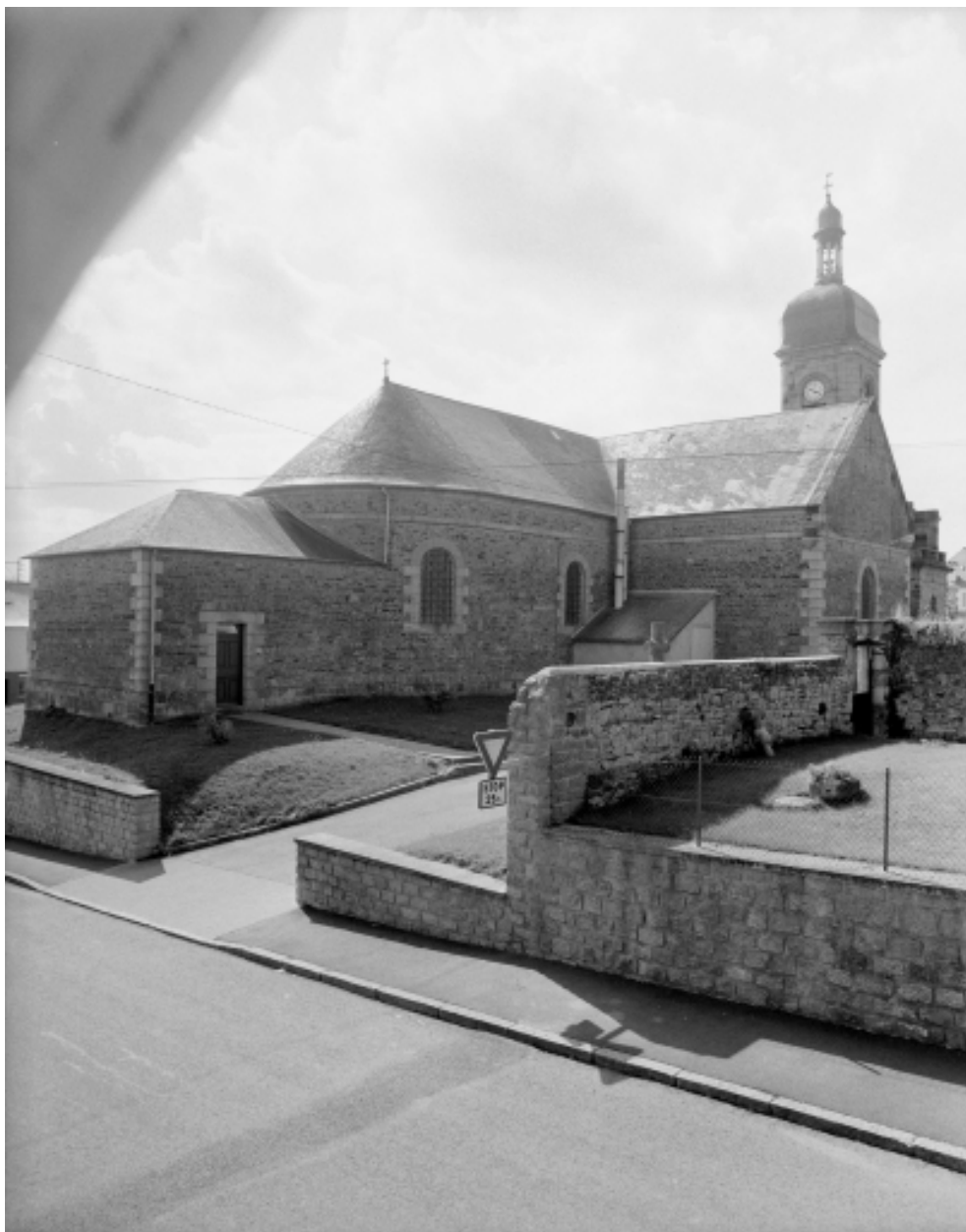
Elévation Nord-Est : vue générale
