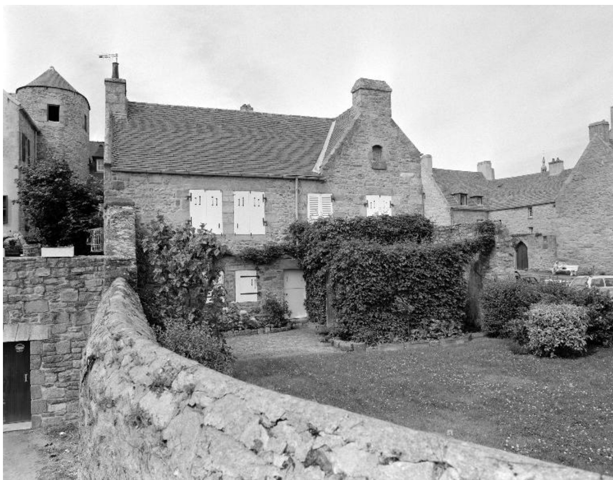
Vue générale du logis n° 2 : élévation nord (état en 1985)
