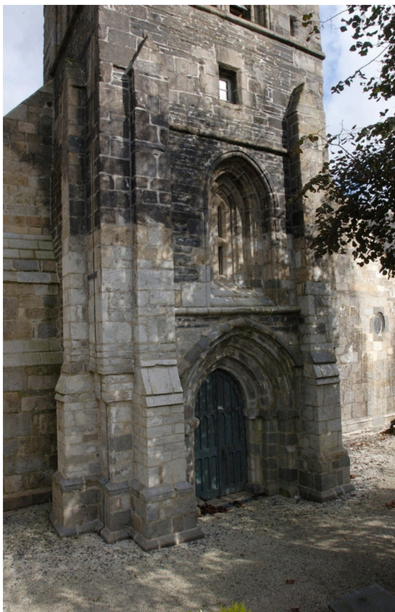
Vue ouest de la tour du clocher
