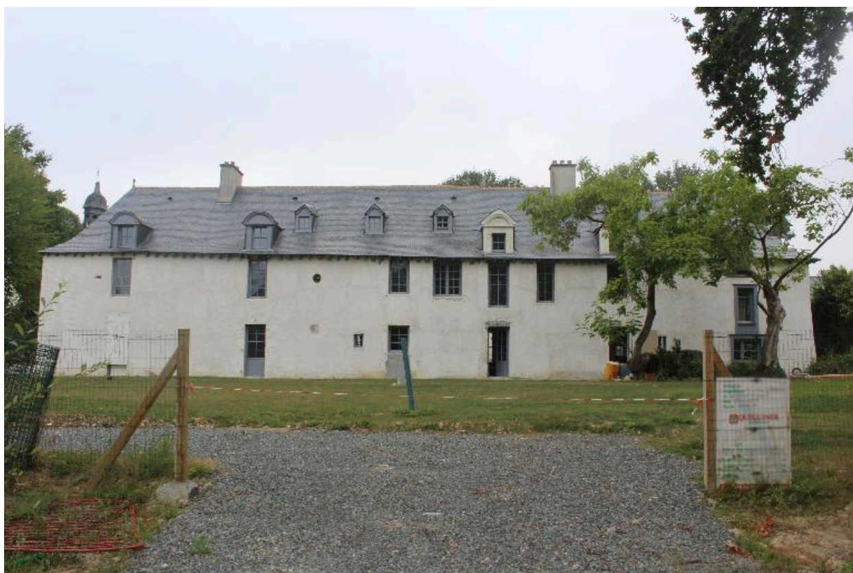
Façade est : vue générale
