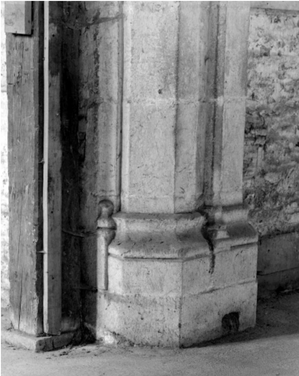
Détail d'une pile du collatéral sud
