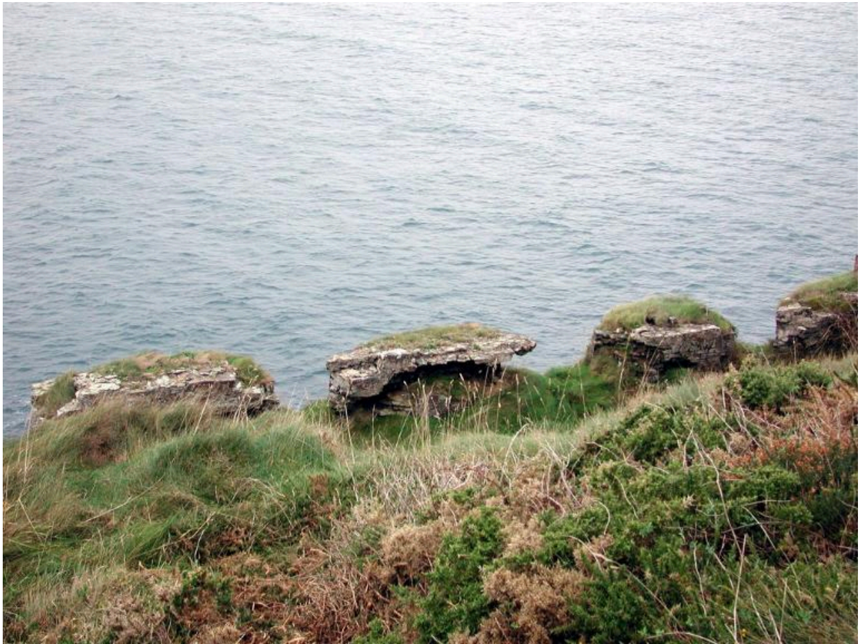
Vue des vestiges du parapet percé d'embrasures (état en 2001)
