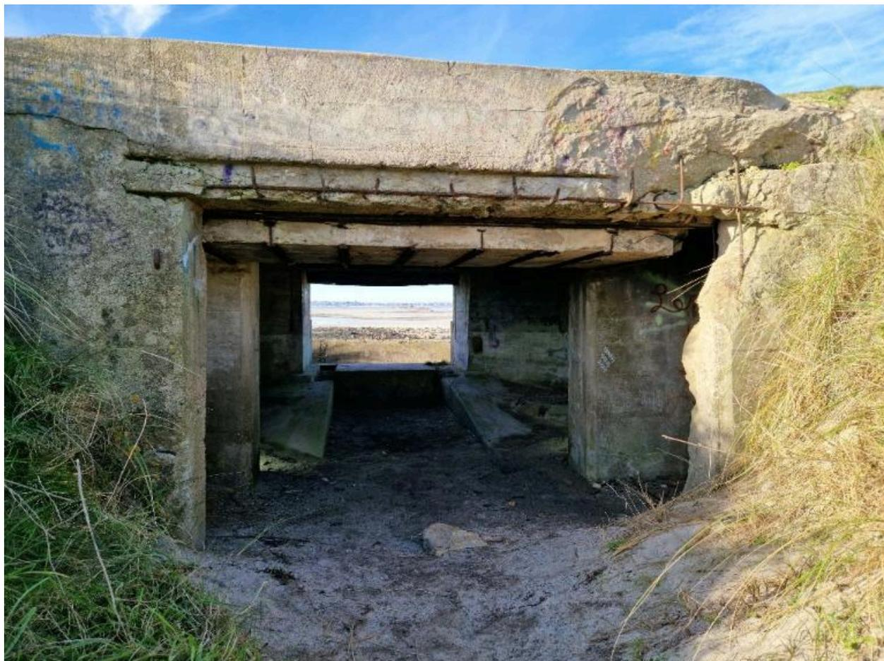
Vue de l'entrée orientée vers l'est. Elle donne accès à la chambre de combat (doté d'une embrasure vers l'ouest), à une niche à munition (à gauche) et au magasin aux munitions (à droite)
