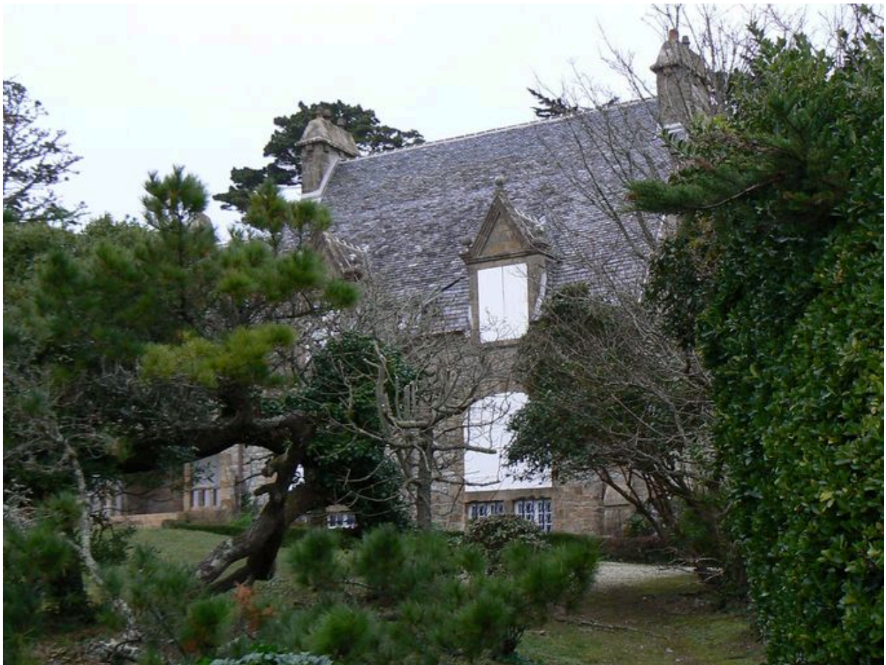
Vue de la villa Les Grottes, côté mer
