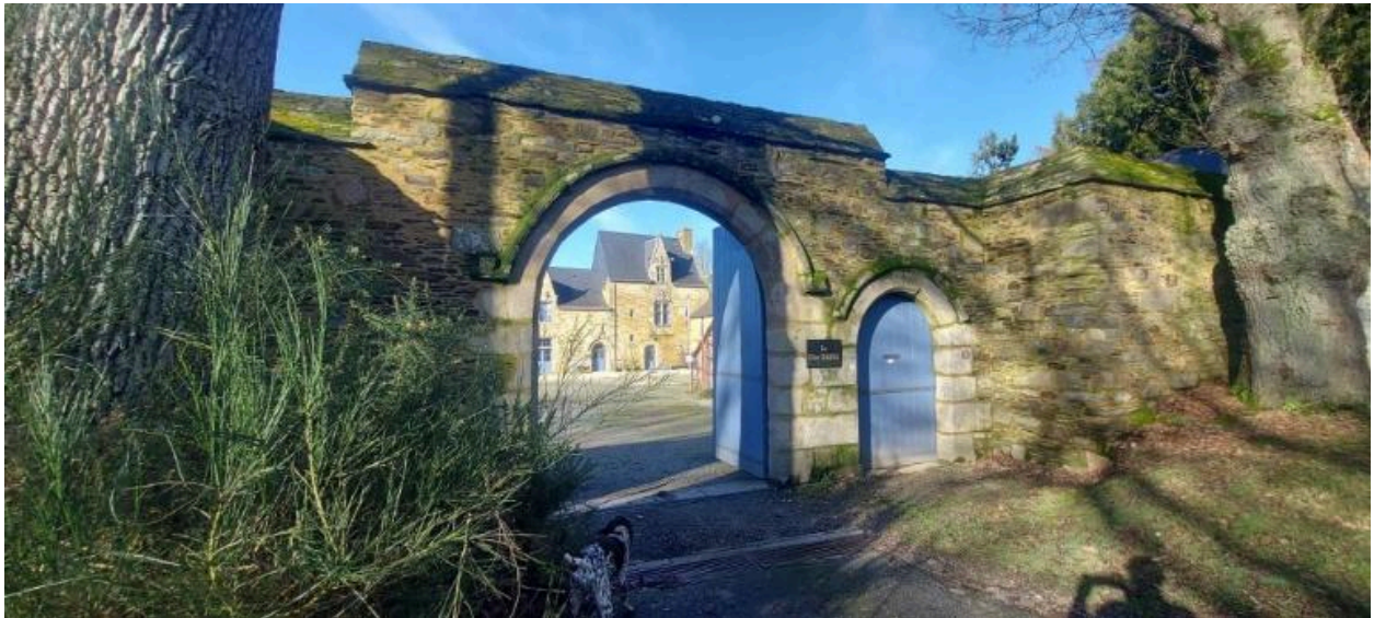
Porte charretière et porte piétonne, vue est
