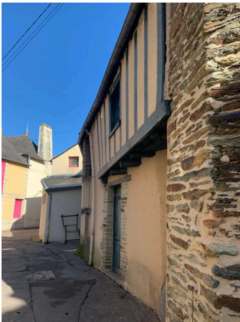
Elévation ouest, partie sud
