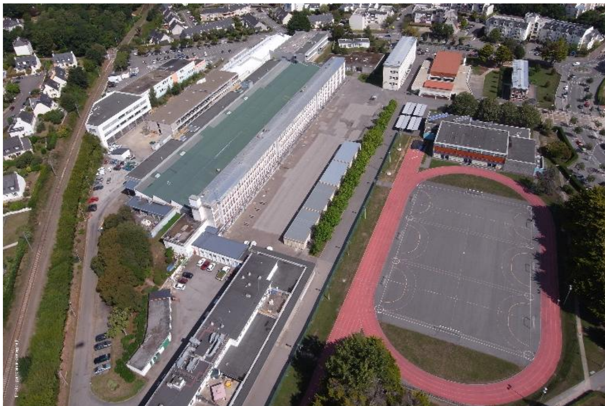
Vue aérienne oblique.
