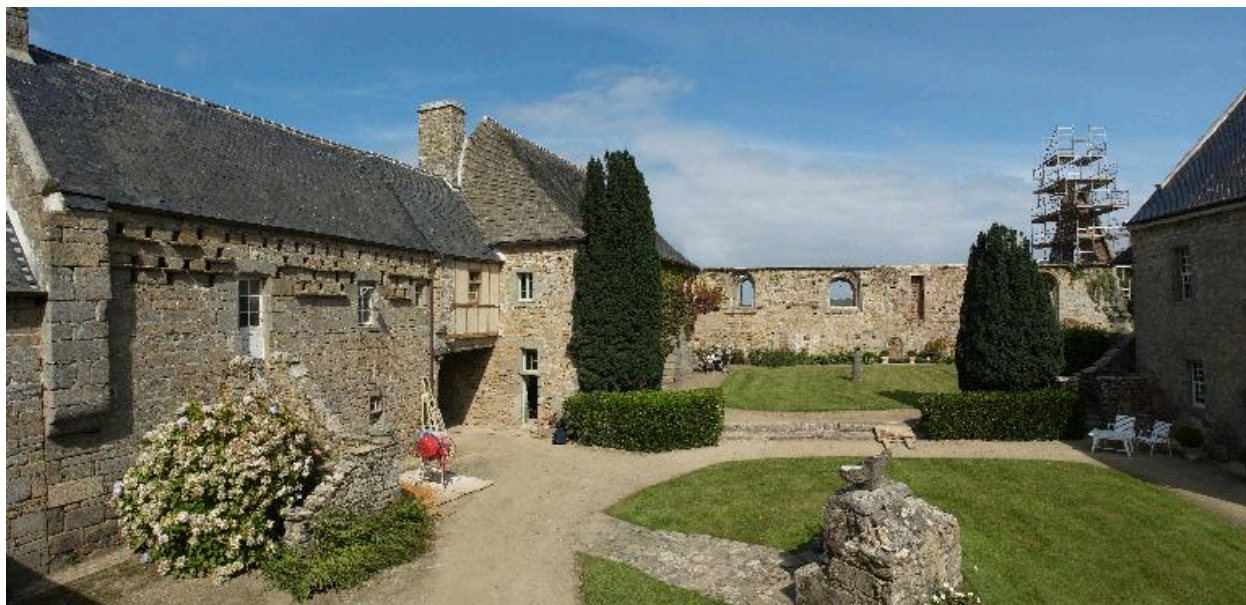
Vue d'ensemble du site depuis le sud-est
