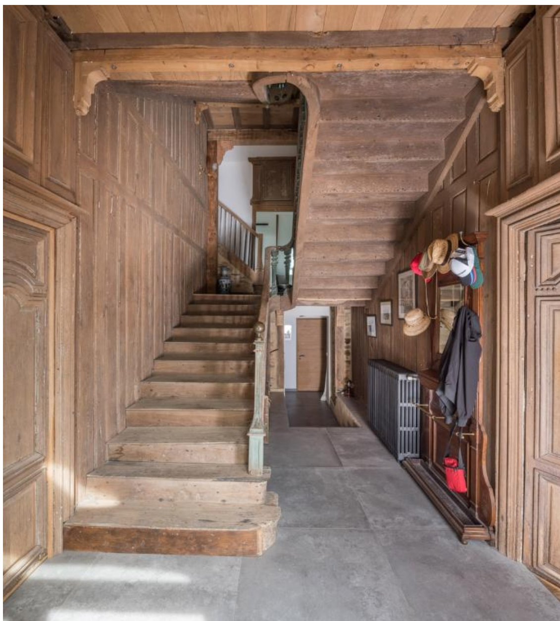
Logis, vestibule d'entrée, escalier construit entre deux cloisons de menuiserie, vue générale
