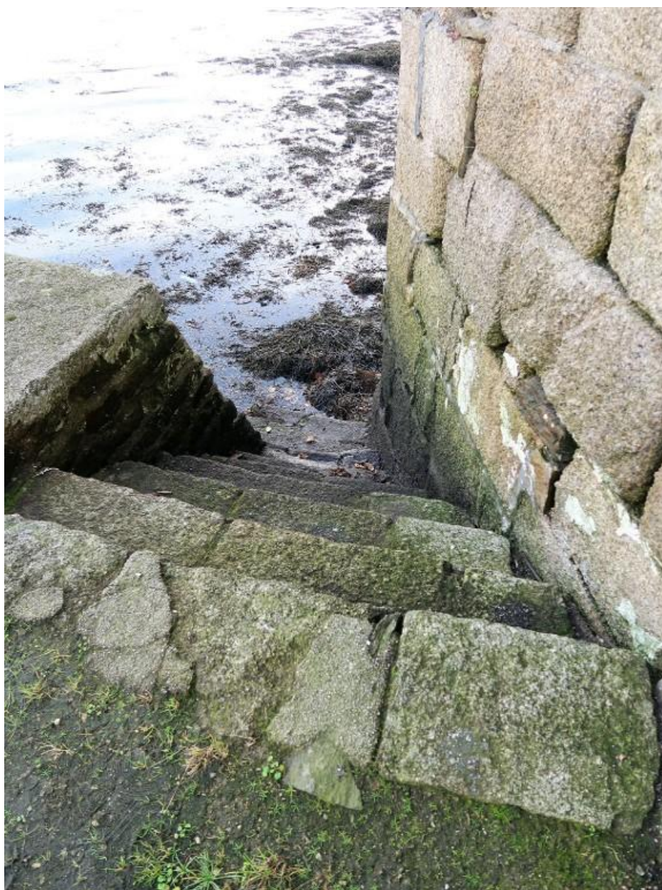
Escalier du quai au vin
