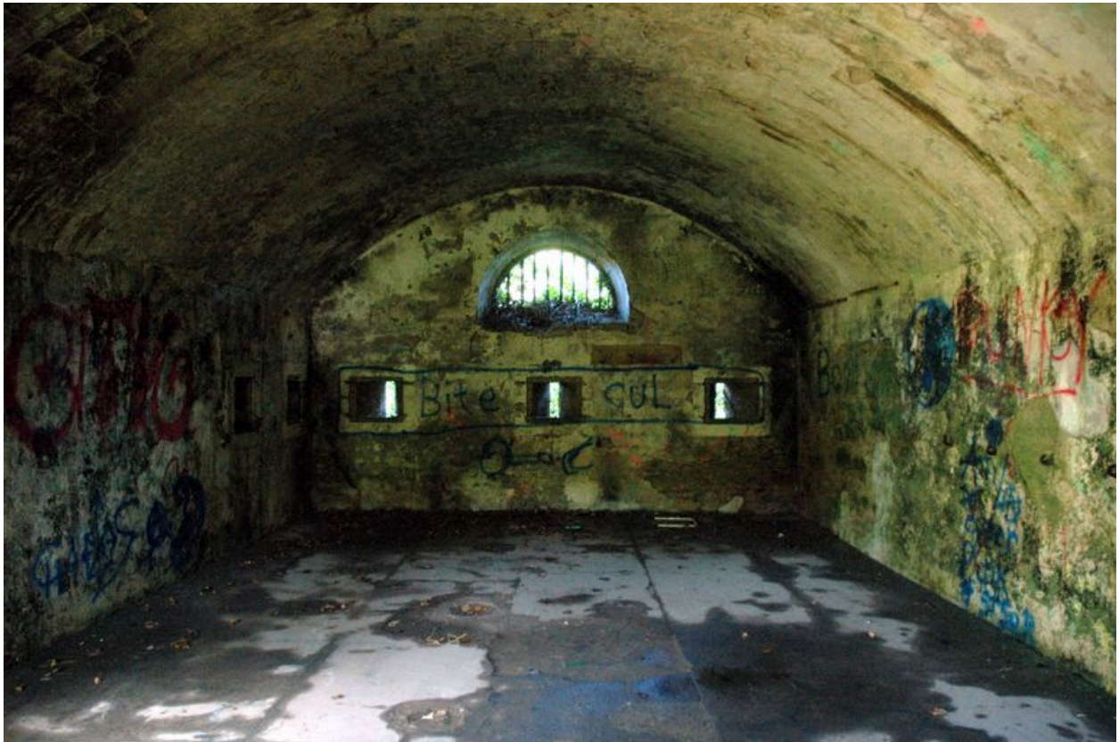
Vue de la chambrée de soldats sud (état en 2006). Sur le mur du fond, haute baie barreaudée et créneaux de fusillade. Sur le mur latéral à gauche, créneaux du sas d'entrée
