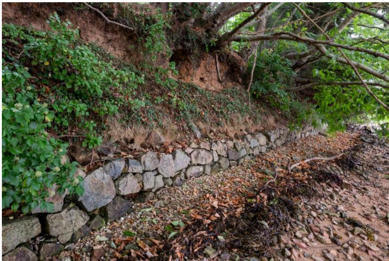
Mur de soutènement sur la rive ouest de la baie de l'Enfer
