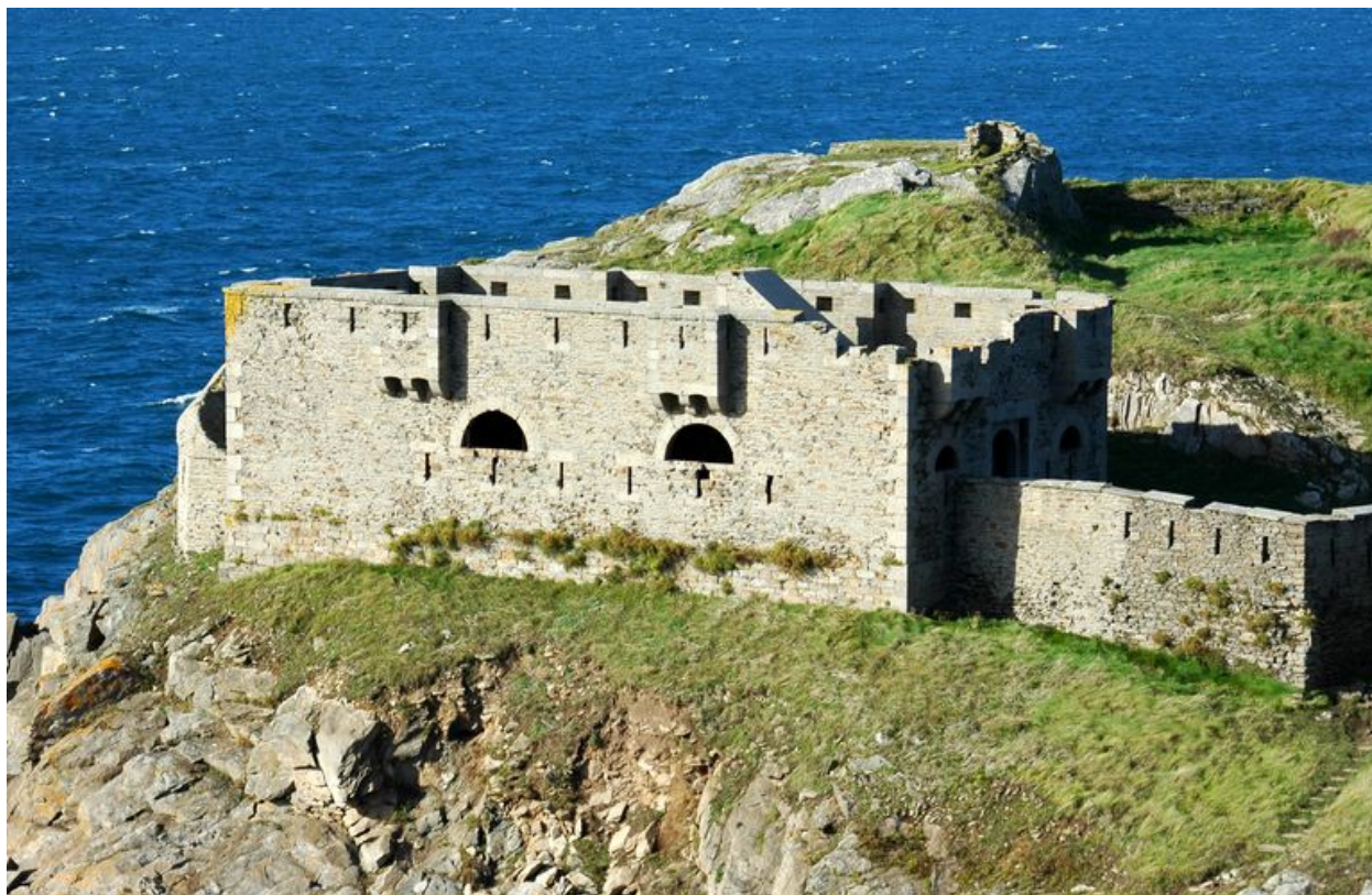
Vue du réduit de batterie de côte de l'Îlette
