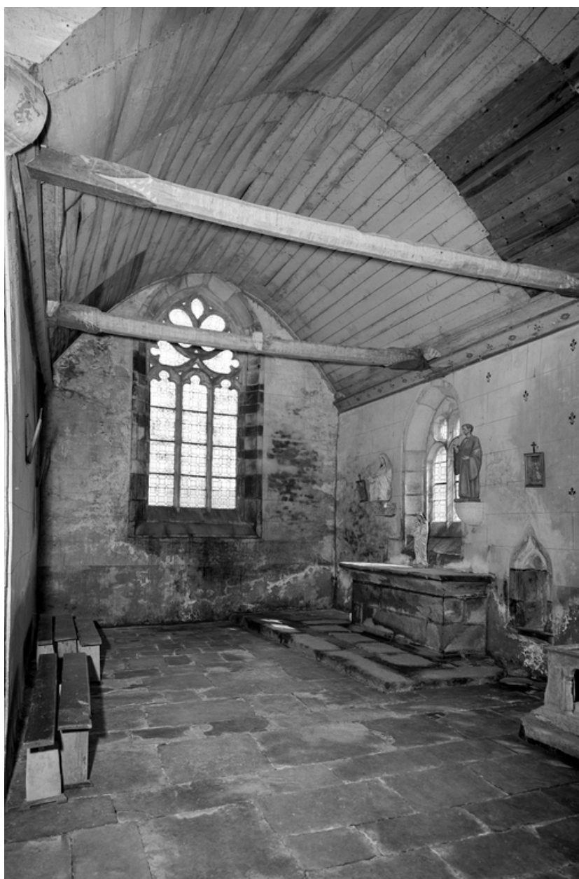
Croisillon nord : vue axiale sud ouest - nord est
