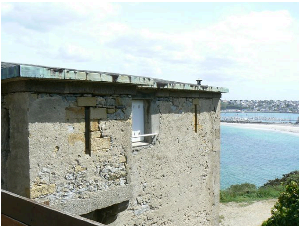
Vue latérale du réduit de batterie de côte du Petit Gouin
