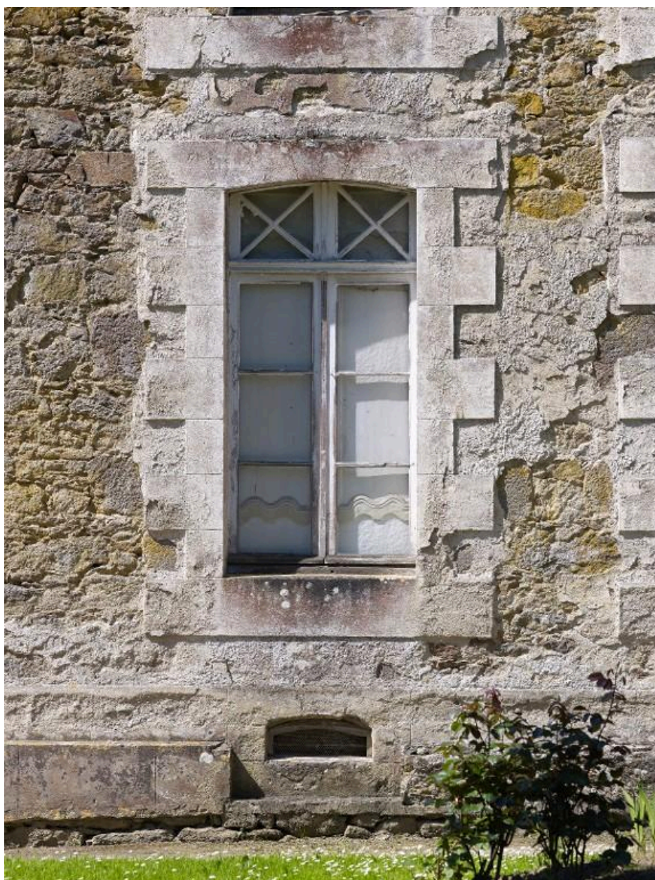
Fenêtre et soupirail du mur est
