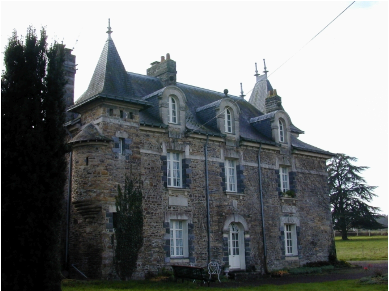
Vue générale nord-est ; noter l'échauguette contenant les latrines à gauche de l'image
