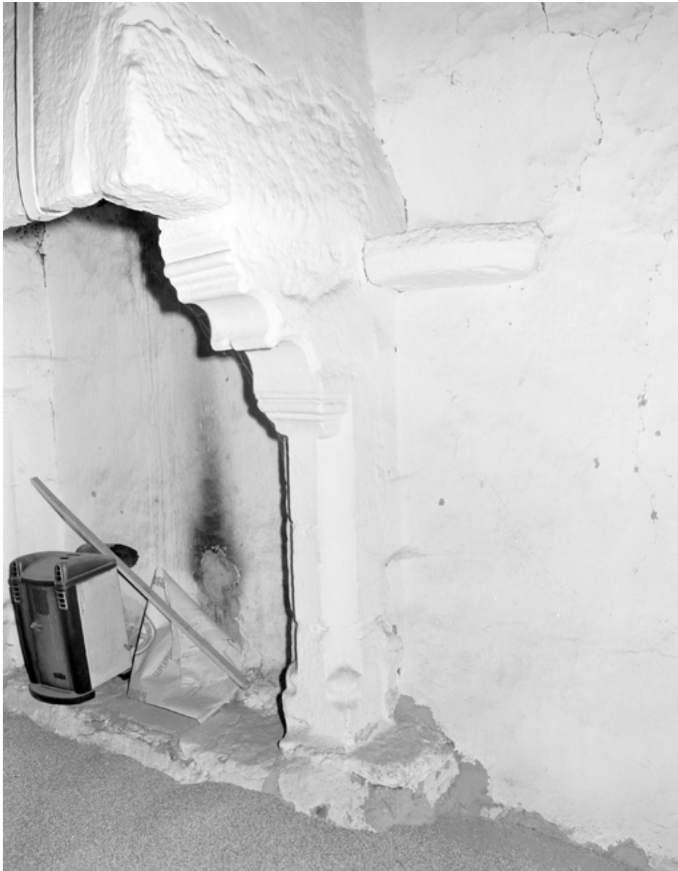
Cheminée, étage, mur est : détail console et haut du piedroit
