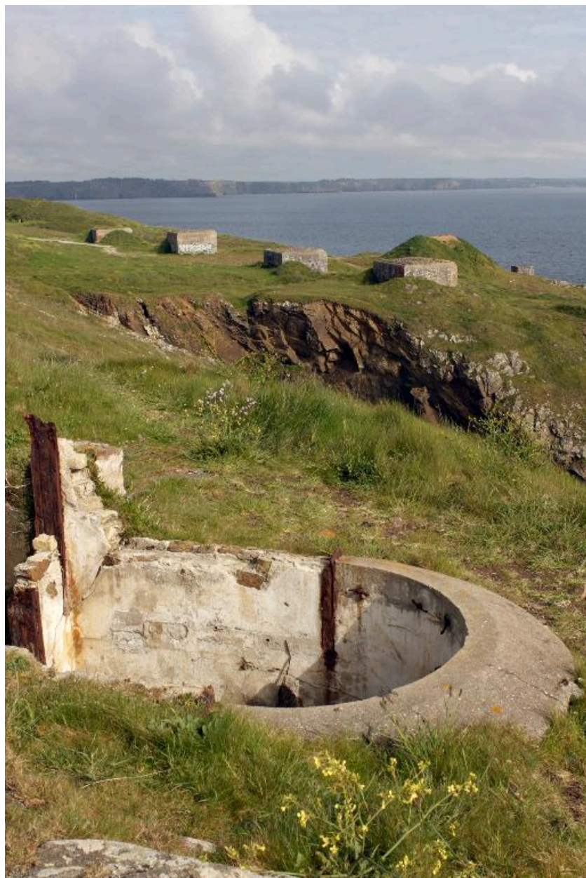
Vue du poste de commande de projecteur (état en 2009)
