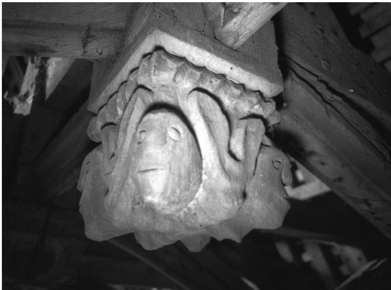
Charpente, détail de la clé 15.
