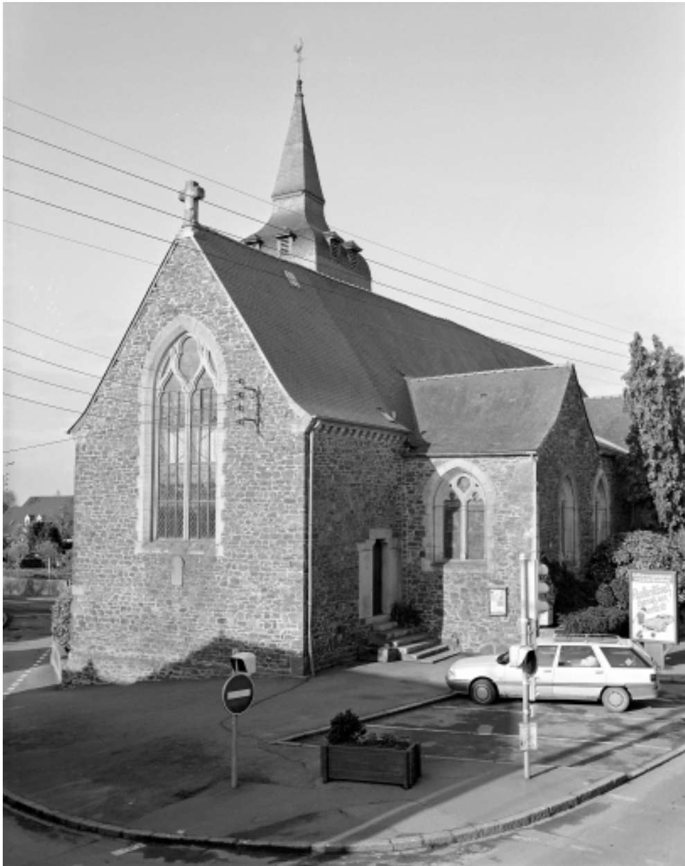
Elévation Est : vue générale
