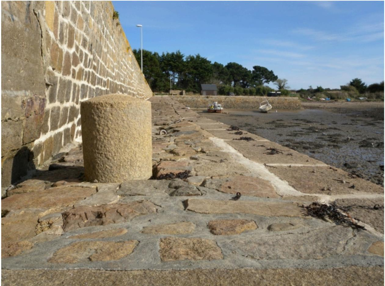
Vue d'un bollard ou borne d'amarrage à l'extrémité de la cale
