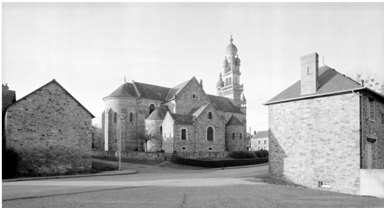
Elévation Sud-Ouest : vue générale
