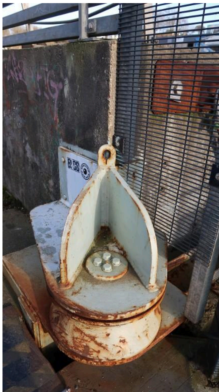
Aire de réparation navale : forme de radoub
