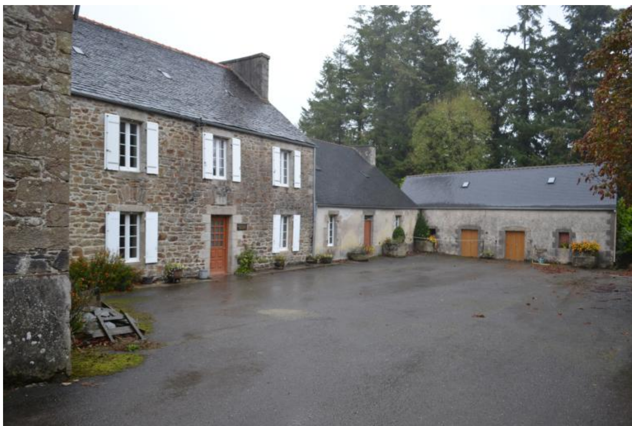
Maison, logis secondaire et atelier de tissage. Vue générale sud-ouest
