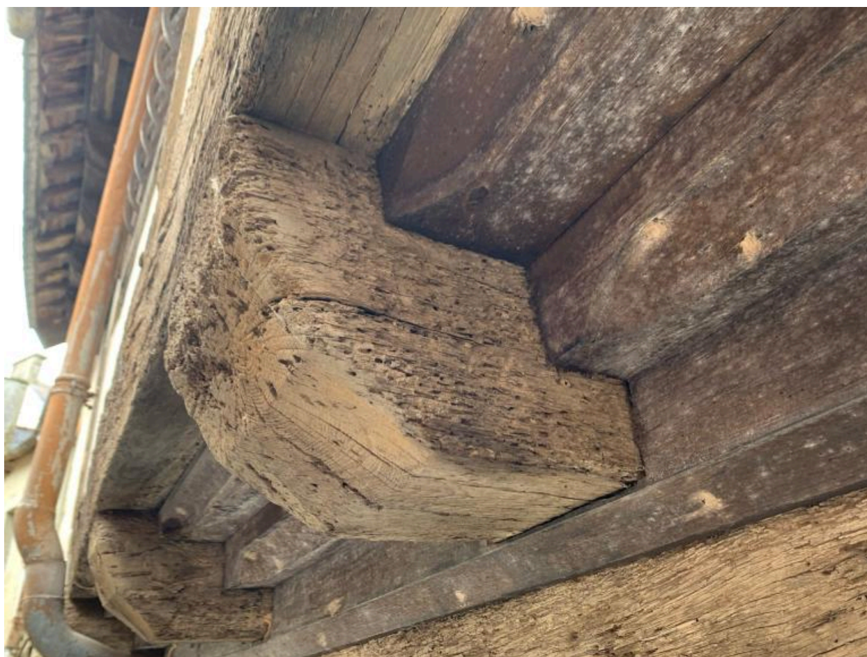
Détail de tête de solive et d'une double entretoise
