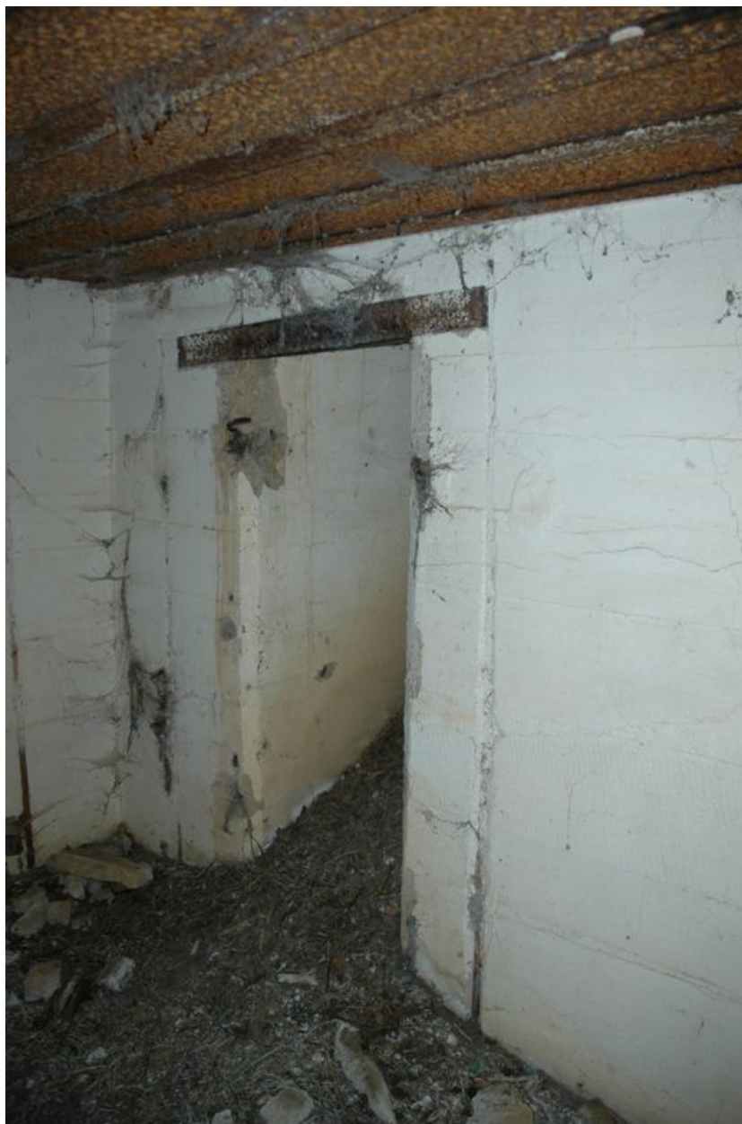
Vue intérieure de l'un des bunkers (état en 2008)
